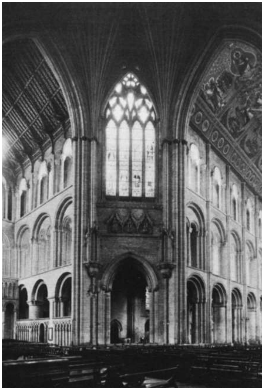
کلیسای جامع ایلی، بخش هشت گوشه: تقاطع گاه با اضافه کردن یک دهانه مورب در هر گوشه که با یک طاق چوبی دارای یک برجک نورگیر پوشیده می شد هشت گوشه گردید.
