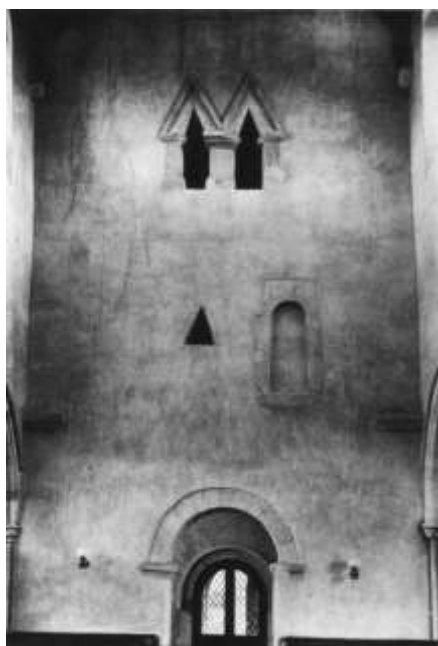
کلیسای سنت مری، دیرهurst، گلاستر شایر: فضای داخلی از طرف دیوار غربی
