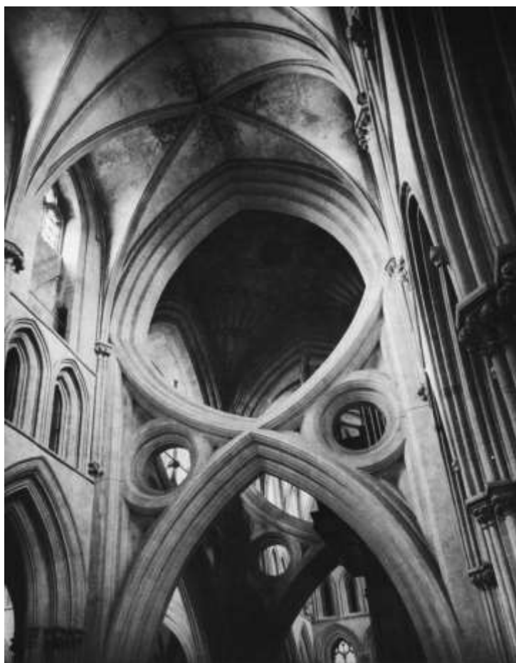
کلیسای جامع ولز: قوس های تقویتی در تقاطع گاه
